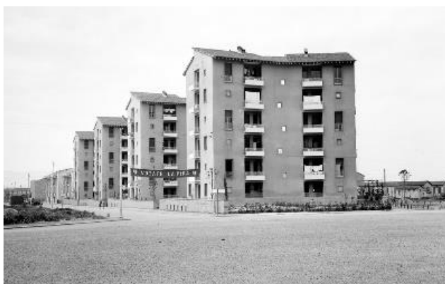
Figura 2 Palazzi in costruzione dell'Ina-Casa, inizio anni Cinquanta
